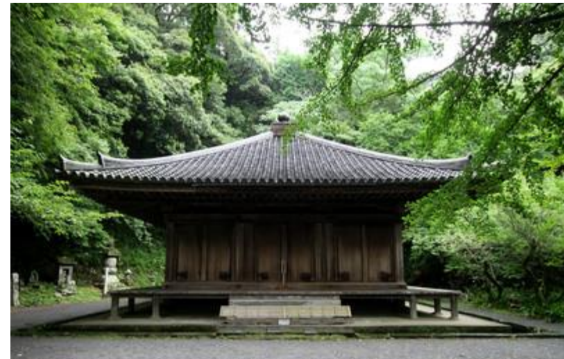
富貴寺： 大堂の屋根は「行基葺き」が使われている
